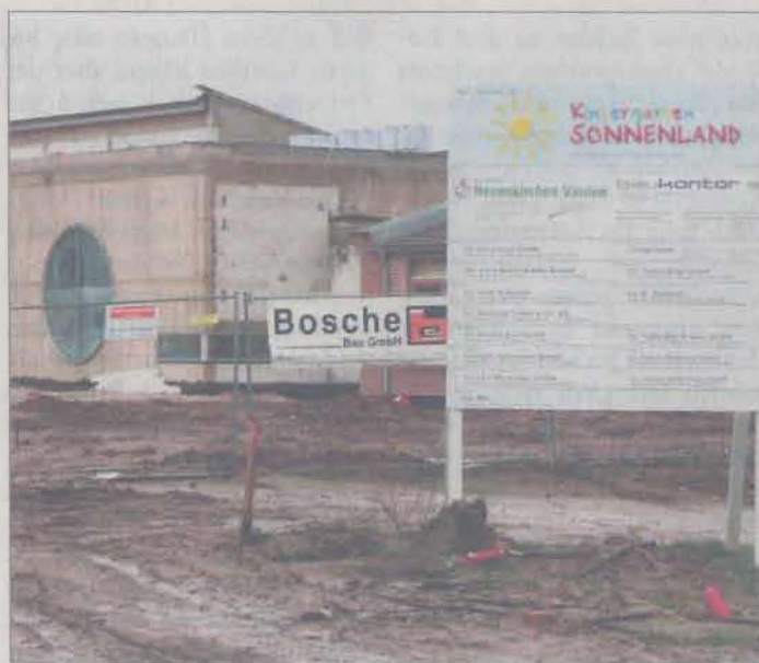
Dem Zeitplan hinterher hinken die Arbeiten am neuen Kindergartengebäude in Neuenkirchen. Foto: Lammert
